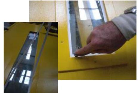
1.- Umieścić bramę na kozłach po stronie zawiasów. Umieścić odpowiednią ilość taśmy papierowej wokół zewnętrznej części ramy okna, aby zapobiec uszkodzeniu skrzydła drzwi. Użyć wyrzynarki do przycięcia zewnętrznej strony mikrowkrętów.
