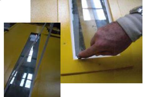
1.- Placez la porte sur des tréteaux du côté des charnières. Placez suffisamment de ruban adhésif en papier autour de l'extérieur du cadre de la fenêtre pour éviter d'endommager le battant de la porte. Utilisez une scie sauteuse pour couper l'extérieur des micro-boulons.
