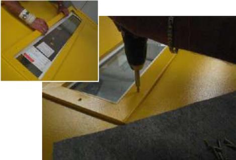
11.- Wywierć otwory w pozostałych punktach mocowania i przykręć pierścień, uważając, aby nie **dokręcić go zbyt mocno, aby nie uszkodzić szkła.**
