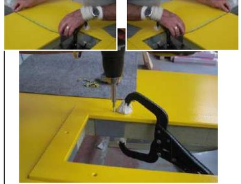
Fissare l'anello alla lama con una pinza a pressione e avvitarlo nei fori previsti con le viti in dotazione.
