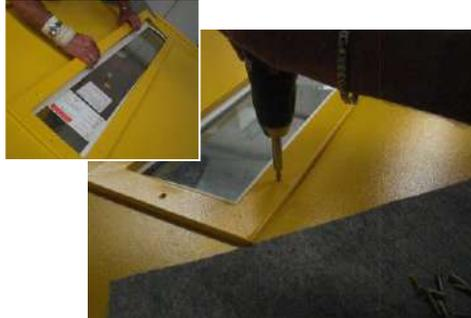
11.- Percez des trous aux autres points de fixation et vissez l'anneau en veillant à ne pas trop serrer pour ne pas endommager le verre.
